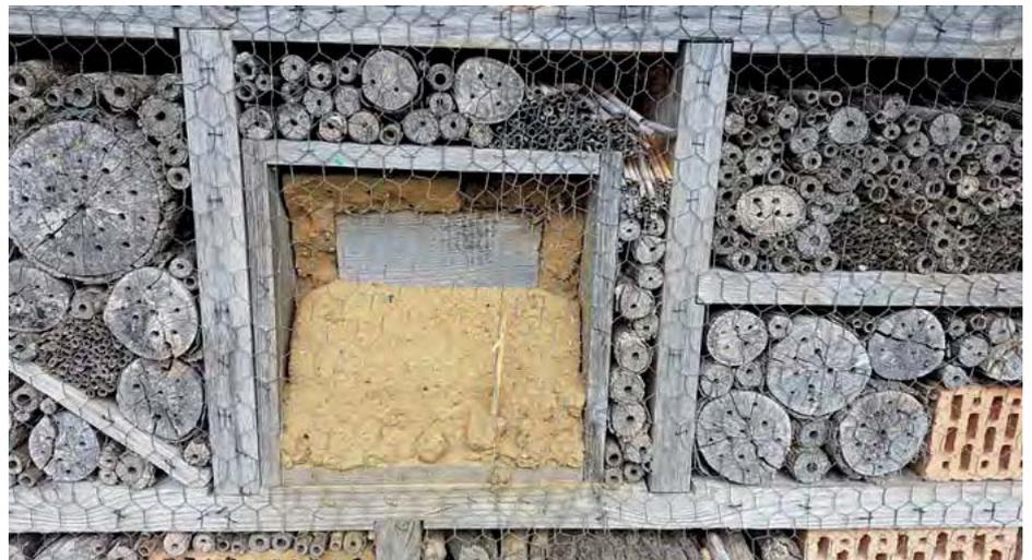
Mangelhaft konstruiertes Insektenhotel mit minimalster Belegungsrate, u. a. mit Holzriegeln und rissigen Stammabschnitten. Das Lössmodul hat bereits Schaden genommen und ist zudem mit kleinen Kiesel durchsetzt, welche unüberwindbare Hindernisse beim Nestbau darstellen. Schade um die vielen Arbeitsstunden. [AH]
